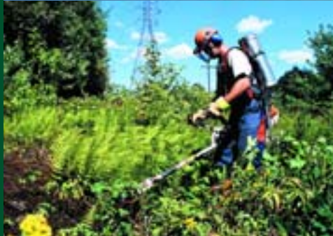
Travaux de maîtrise de la végétation.
