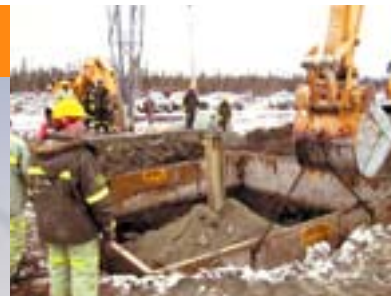
Nouvelles fondations au poste de La Baie.
