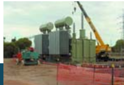
Construction du poste Red Cliffs en Australie.
